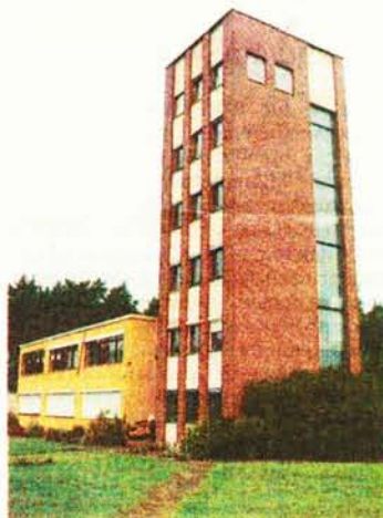
Haus und Turm nutzte der Wetterdienst. Sie müssen erst mal saniert werden.
